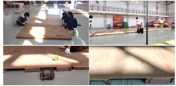
Gambar 7. Dokumentasi perakitan panel landasan kerja dan pemasangan utilitas di laboratorium lapangan PUtech.
