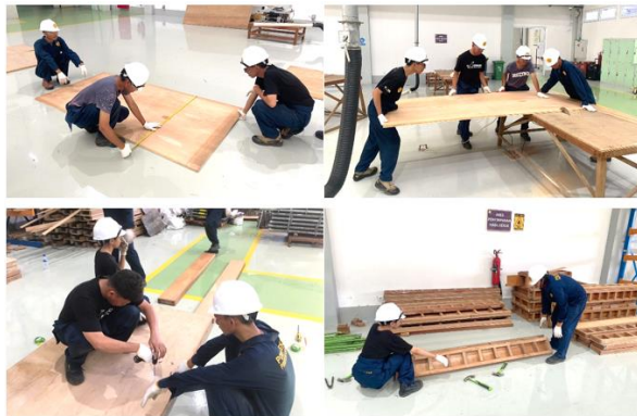
Gambar 6. Dokumentasi pembuatan panel landasan kerja di laboratorium lapangan PUtech.
