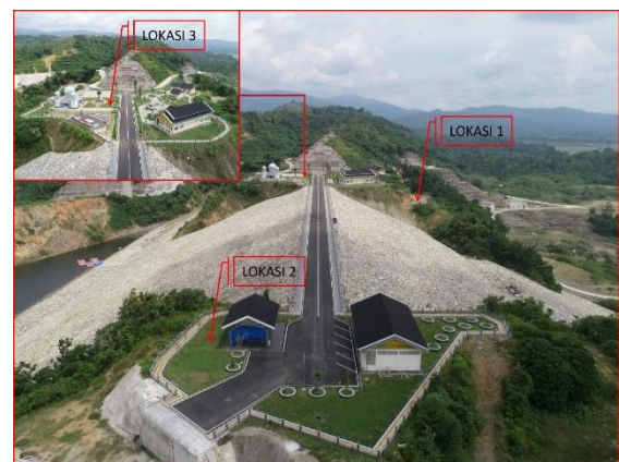
Gambar 2. Lokasi pengukuran. Bendungan Rukoh, Sigli, Aceh
