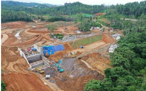
Gambar 6 Kolam Retensi TR-01 pada tahap konstruksi
