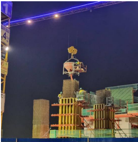
Gambar 4 Pengecoran Core wall dengan concrete bucket
