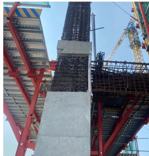
Gambar 5 Blockout pada Core wall
