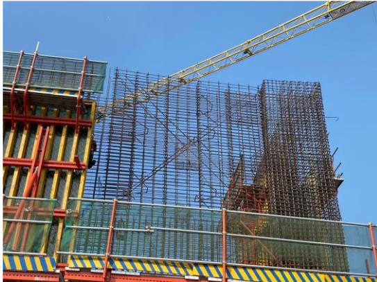
Gambar 3 Penulangan pada Core wall
