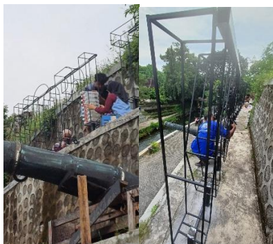
Gambar 7. Proses Pelaksanaan Pemasangan Branding Kuliner Kopi Talud
