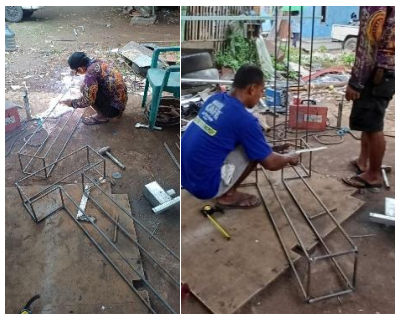
Gambar 6. Proses Pembuatan Rangka di Bengkel Besi
