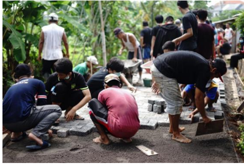
Gambar 10. Pemasangan lapis perata 1-4 cm
