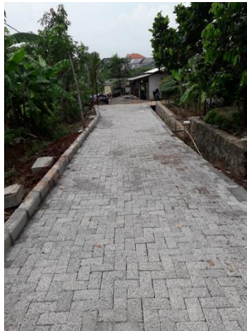
Gambar 12. Pemasangan lapis perkerasan interblok
