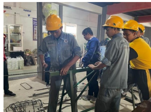
Gambar 2. Proses Pembengkokan baja
